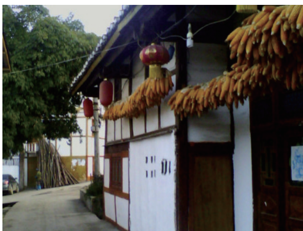
图片 1—4 墙白瓦黑 卫生文明 贵州新农村建设——贵阳市乌当区王岗村
